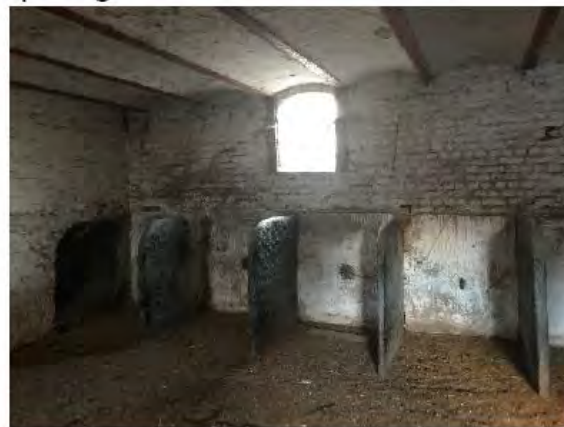
koeienstal: tussenschotten in doornikse blauwsteen
