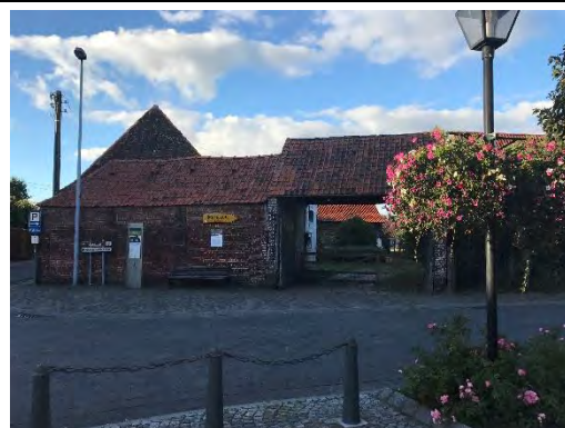
Foto 2: Poortgebouw vanop Sint-Jansplein
