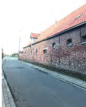
Foto 3: gevel stalvleugel Schoolstraat
