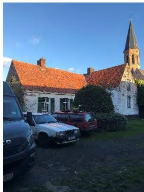
Foto 11: gevel hoevewoning (zicht vanaf binnenkoer)
