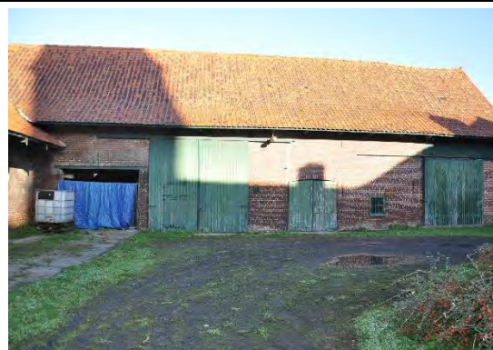
Foto 6: gevel dwarsschuur binnenkoer
