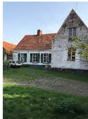
Foto 12: gevel hoevewoning (zicht vanaf binnenkoer)
