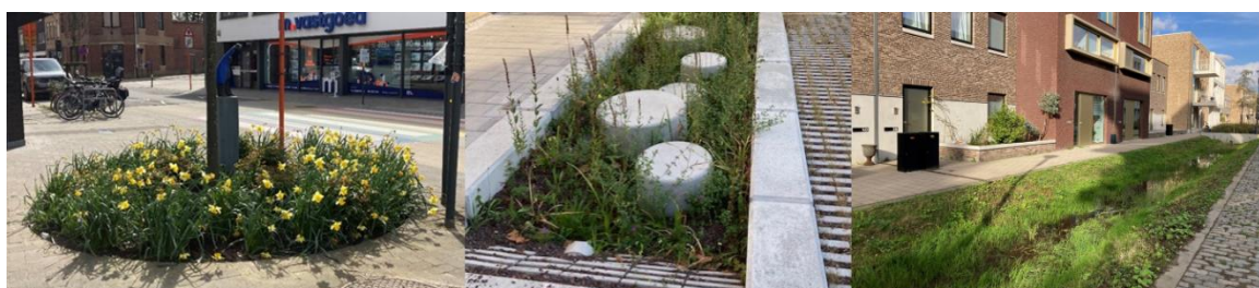
Figuur 31. Voorbeelden van lokale buffer- en infiltratievoorzieningen. © Aquafin
