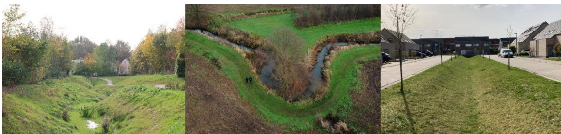
Figuur 32. Blauwgroene afvoerwegen bieden een breed spectrum aan inrichtingsmogelijkheden. (Links) Vuilbeek te Wezembeek-Oppeem als blauwgroene verbinding ©VMM; (midden) meanderende beek met bufferstroken ©VMM; (rechts) verlaagd aangelegde groenzone in een woonwijk in Kortrijk © Aquafin.
