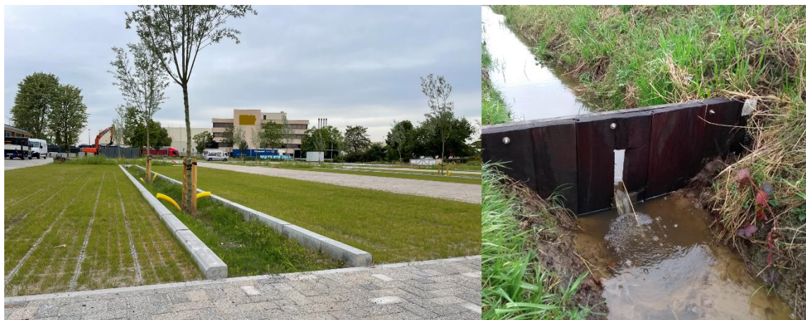
Figuur 6. Voorbeelden van mogelijke maatregelen om afstroom te vermijden van (links) verharde oppervlaktes (parking Aquafin, Aartselaar) en (rechts) in een afvoergracht via een (knijp)stuw (Maldegem). © Aquafin
