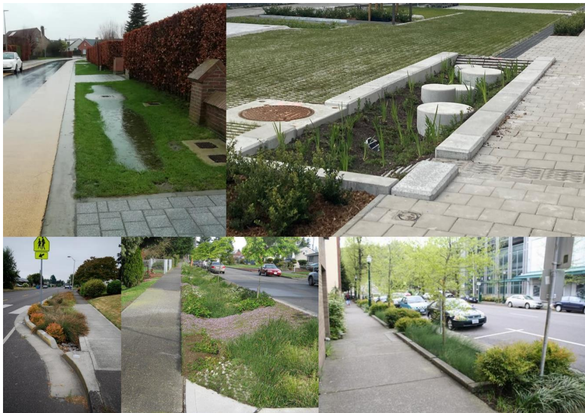
Figuur 23. Vlnr en vbno: (1) Infiltratiekom langs de straat. © Kruisem; (2) Bufferend plantvak (Aziëlaan Wilrijk, tuinstraat). © Aquafin; (4, 5 en 6) Mogelijke vertragsmaatregelen waarbij de inplanting zoveel mogelijk wordt uitgespreid en focust op water vasthouden. © Aquafin.
