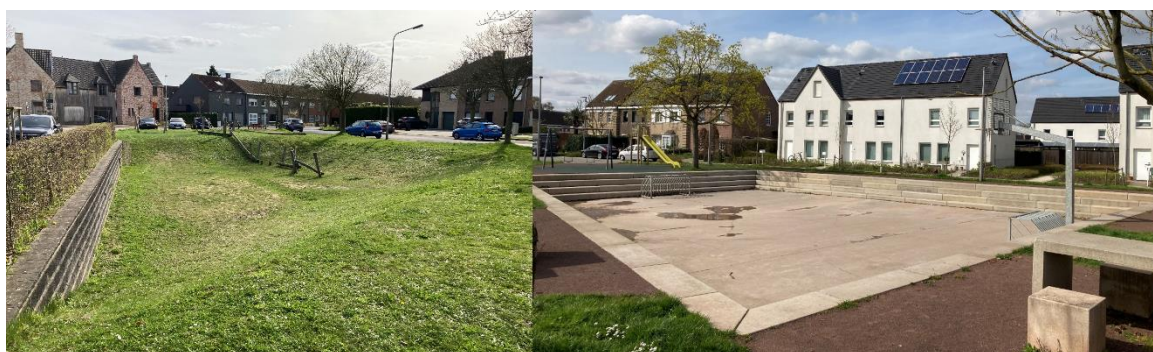
Figuur 10. Voorbeelden van buffervoorzieningen: (links) verlaagde groen-/speelzone (Kortrijk) en (rechts) verlaagd aangelegd basketbalplein (Kortrijk). © Aquafin
