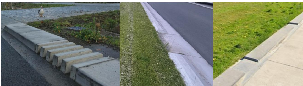
Figuur 28. Voorbeelden van een boordstenen met spleten: (links) in de Fortstraat in Mortsel. Bron: dbpubliekeruimte.info, (midden) in Catershoflaan in Merksem © Aquafin en (rechts) in de Krakeelhoestraat in Kortrijk. Bron: Google Maps.
