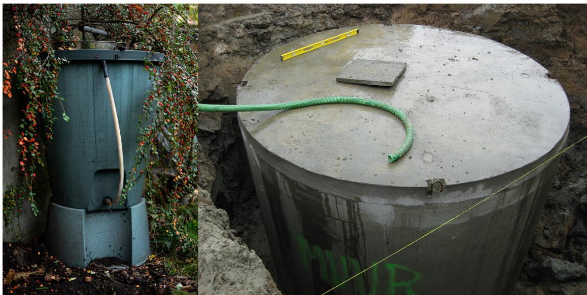
Figuur 7. (Links) regenwaterton en (rechts) regenwaterput. © Aquafin
