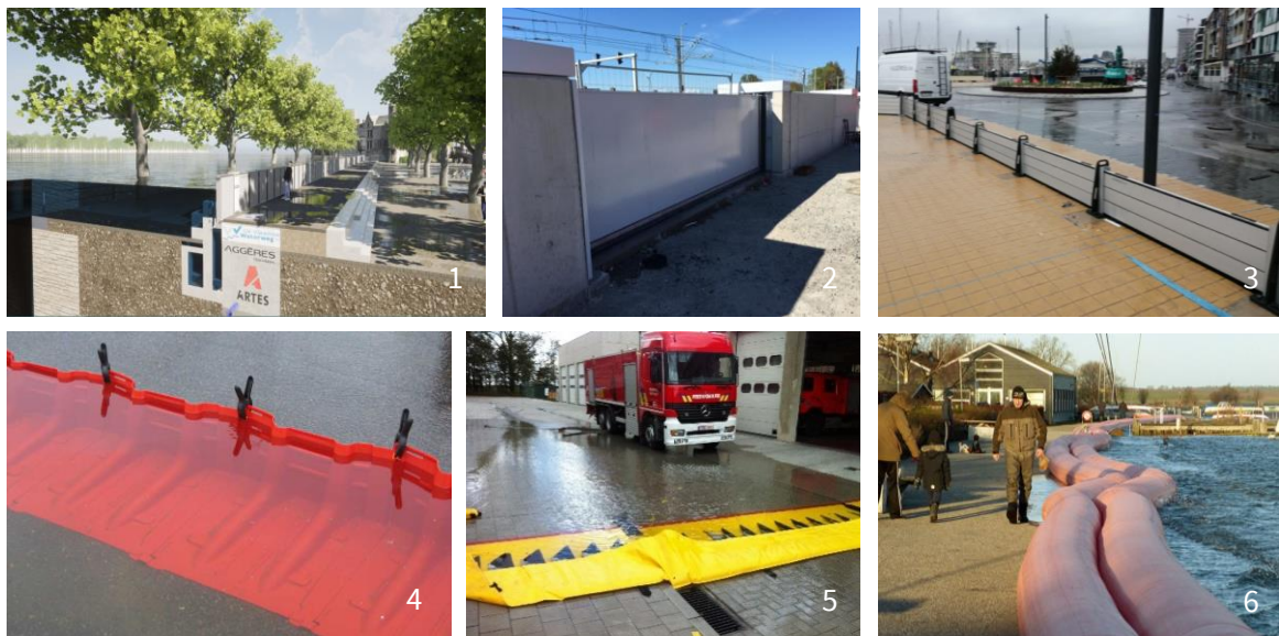
Figuur 34: Voorbeelden van mobiele waterkeringen. (1) Nieuwe mobiele waterkering aan Scheldekaaien in Antwerpen (Sigmoidplan, 2024); (2) Mobiele rolpoort in de vaste stormmuur in Zeebrugge (AMDK, 2024); (3) Manueel te plaatsen stormmuur in Oostende (AMDK, 2024); (4) Kliksysteem van Boxwall (© Boxwall); (5) Modulair systeem Velox van Aggères (© Aggères); (6) Opvulbare buis van Aqwatt (© Aqwatt)
