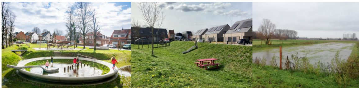
Figuur 30. Bovenlokale buffers kunnen meerdere functies combineren. Links en midden wordt de bufferfunctie gecombineerd met een recreatieve functie, waar de foto rechts infiltratie en buffering combineert. Locatie: (links) Kontich, (midden) Kortrijk en (rechts) Kruisem. © Aquafin
